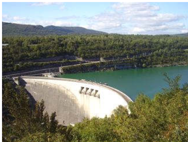
Le barrage de Vouglans.
