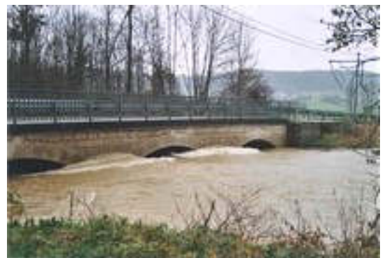
Saint-Germain-les-Arlay, pont du Tortelet, cru de la Seille, avril 2005. © DDT du Jura.
