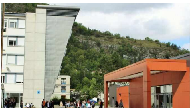
La Cité scolaire du pré-Saint-Sauveur à Saint-Claude - crédits : eclat-bfc.fr
